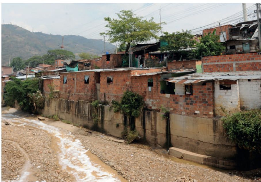
Figura 7. Vista de viviendas en condición de amenaza por inundación
